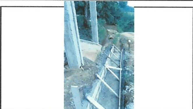
Foto 3: cuneta de acceso y muros para el portón
